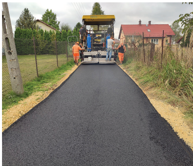
Asfaltowanie ul. Świerkowej
